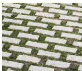
Pavage en béton avec ouvertures de drainage
