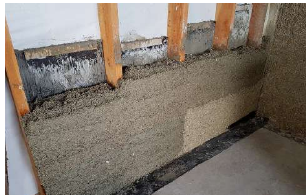
exemple de mise en œuvre d'isolation par l'intérieur, bâtiment
