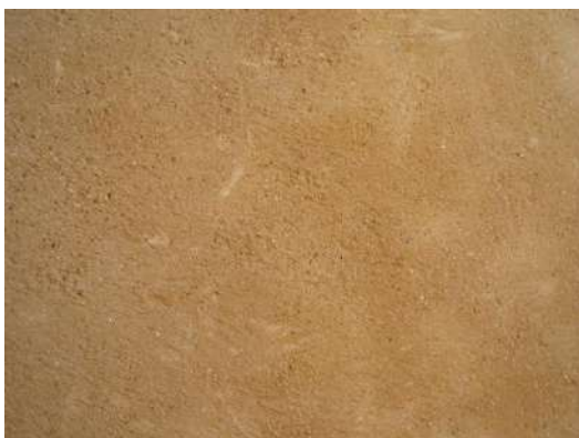
exemple d'enduit de finition à la chaux
