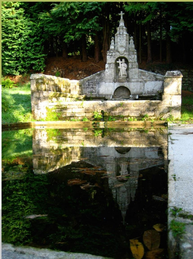
Fontaine maçonnée associée à une chapelle au nord de Bubry
