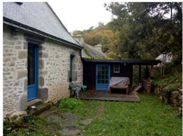
Figure 3: Sas d'entrée construit en 2020
