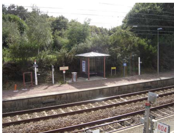
Halte ferroviaire - Quai
