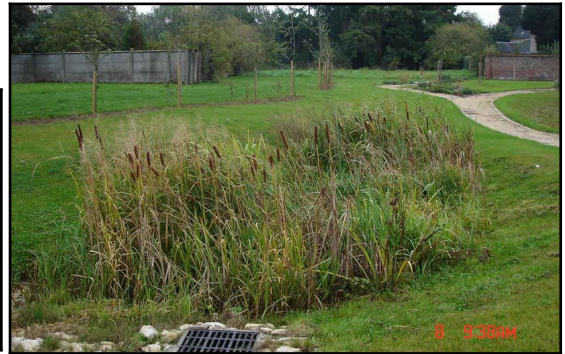
Source : Bassin d'eaux pluviales à Crevecoeur le Grand (60)
