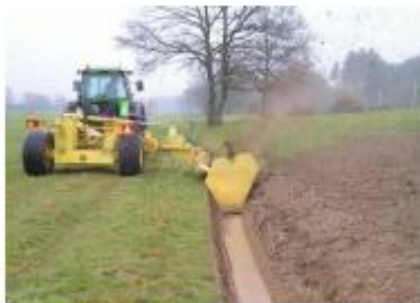
Figure 37 : Exemples de curage et reprofilage de fossé
