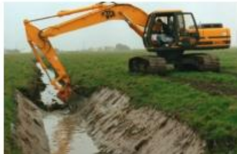
Figure 37 : Exemples de curage et reprofilage de fossé
