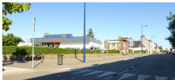
Le parking « de devant », l'architecture en « galette » contribuent à la rupture de la continuité urbaine
