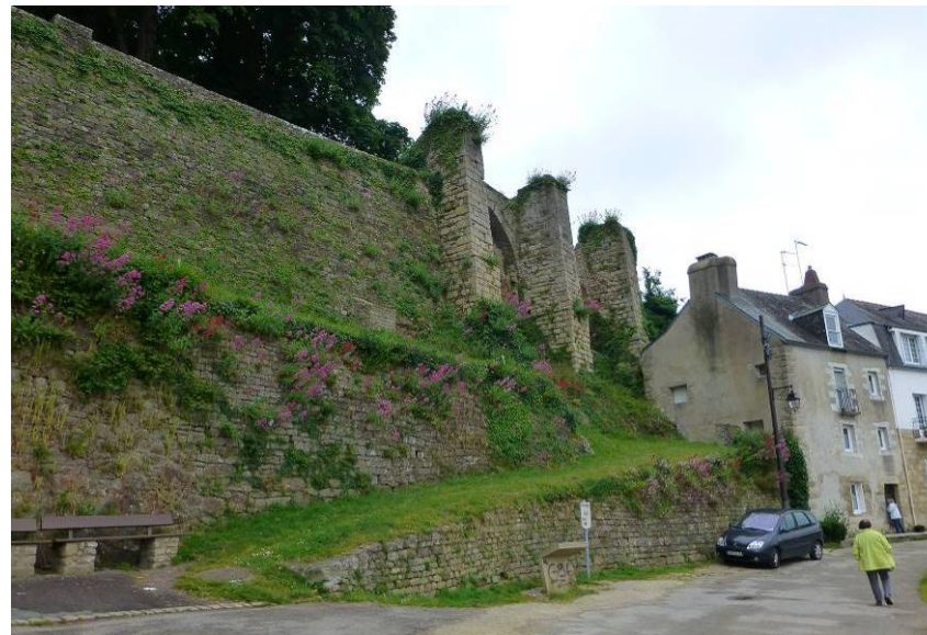
Les rampes, en contrebas du mur d'enceinte et des contreforts de l'ancien château
