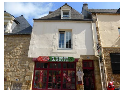
Rue du Château (17 e siècle)
