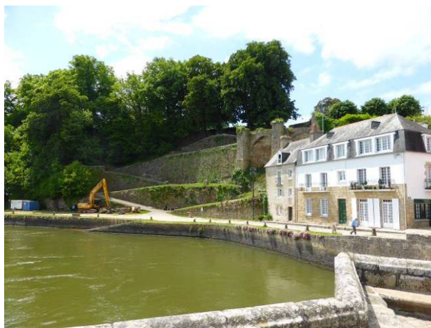
Les vestiges du corps de logis du château épaulés de contreforts dominant le quai Martin.
