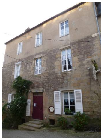
Maison de l'alloué du sénéchal d'Auray édifiée à partir de 1578. Rue du Château.
