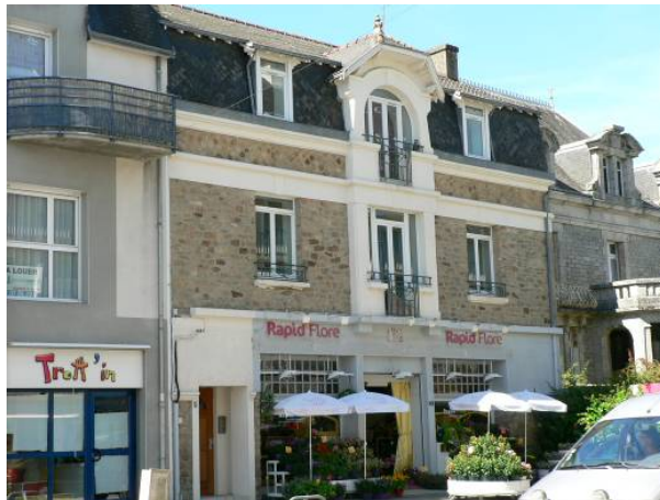
Avenue du Maréchal Foch. Immeuble Art Déco
