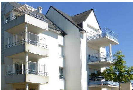
Des balcons aux dimensions excessives
