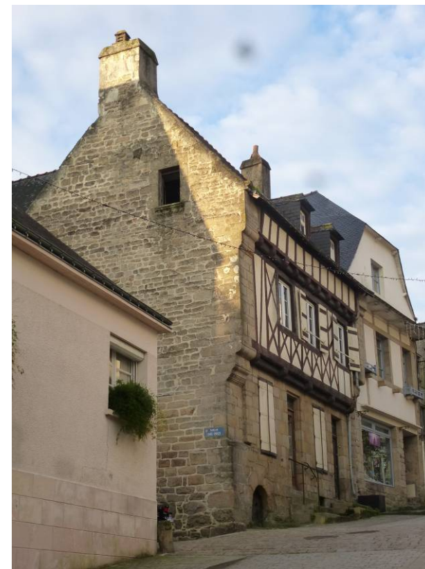
Rue du Château (début 17 e siècle) Les rampants du pignon et les têtes du refend, soigneusement appareillés en pierre de taille, accompagnent le parement moellonné du mur.
