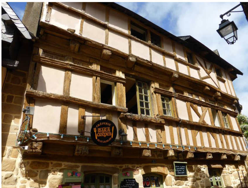
Rue Saint-René, Saint-Goustan
