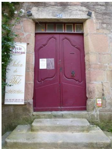
Rue du Château (17 e siècle ?)
