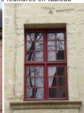
A gauche, rue du Château, façade du 17 e siècle dont les fenêtres étaient dotées de croisées en bois. La menuiserie actuelle est à deux battants en PVC. L'encadrement en pierre, à arêtes vives, était à l'origine dépourvu de contrevents – la baie était fermée par des volets intérieurs. A droite, exemple de menuiseries réalisées à partir de modèles du 17 e siècle
