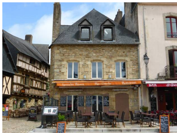
Place Saint-Sauveur, Saint-Goustan (19 e siècle) L'absence d'enduit perturbe la cohérence de la façade composée ici en travées
