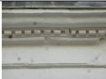
Rue du Château Corniche profilée d'un talon et agrémentée de denticules
