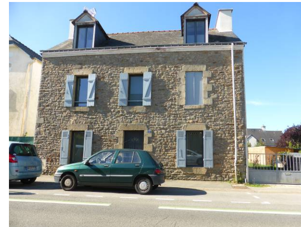
Rue Philippe Le Gall (19 e siècle) Le parement en moellons laissés visibles atténue le parti architectural fondé sur le dessin des encadrements de baies harpés.
