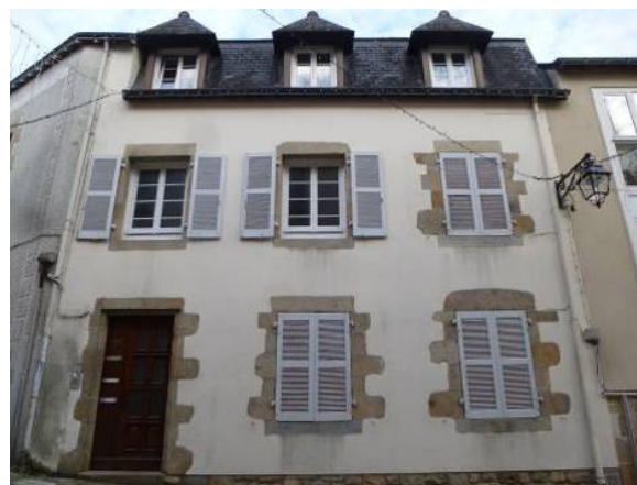
Rue du Château (19 e siècle)
