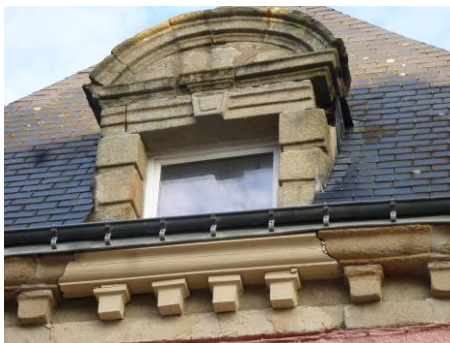
Rue du Château. Lucarne en pierre à fronton curviligne
