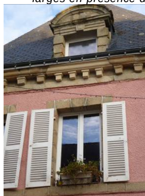
A gauche, rue du Château, façade du 17 e siècle dont les fenêtres étaient dotées de croisées en bois. La menuiserie actuelle est à deux battants en PVC. L'encadrement en pierre, à arêtes vives, était à l'origine dépourvu de contrevents – la baie était fermée par des volets intérieurs. A droite, exemple de menuiseries réalisées à partir de modèles du 17 e siècle
