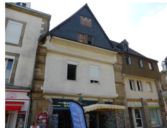
Rue du Château (16 e siècle)
