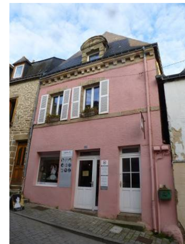
Rue du Château (17 e siècle)
