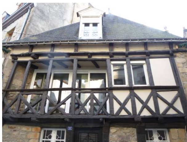
Rue du Belzic (16 e siècle) Registre des anciennes fenêtres en succession souligné par un cordon d'appui filant sur toute la longueur de la façade.
