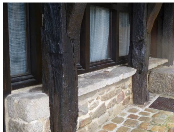
Rue Saint-René, Saint-Goustan. Les étals maçonnés englobent les faces latérales et arrière des poteaux porteurs.
