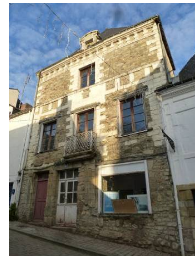
Rue du Château (vers 1650). Carroyage en tuffeau.
