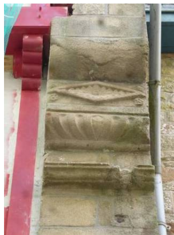
Rue du Château (16 e siècle)
