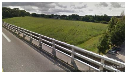
Au sud du viaduc l'espace ouvert entre celui-ci et Kerplouz doit être maintenu dégagé
