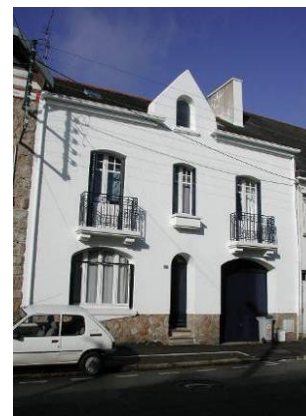
Lotissement du Chemin noir. Rue Jean Jaurès.
