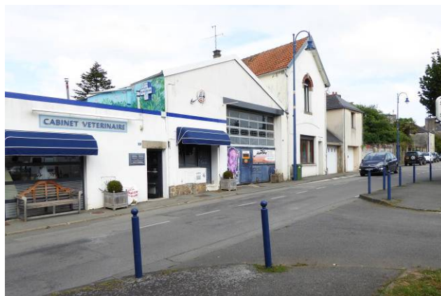
Bâti susceptible de « muter » du 3 au 9 rue des Ecoles
