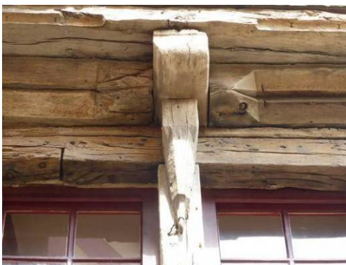
Rue du Petit Port, Saint-Goustan (entretoise et consoles du 16 e siècle)
