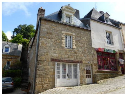
Rue du Château (17 e siècle)
