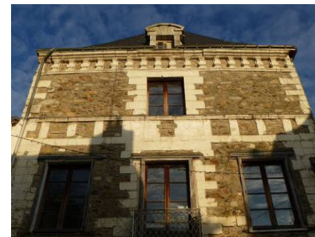
Rue du Château (17 e siècle)
