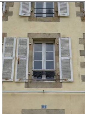
Place de la République. Composition « classique » des menuiseries du 19 e siècle : deux battants en bois à 6 ou 8 carreaux, avec contrevents persiennés ou à lames larges en présence de feuillures en tableau
