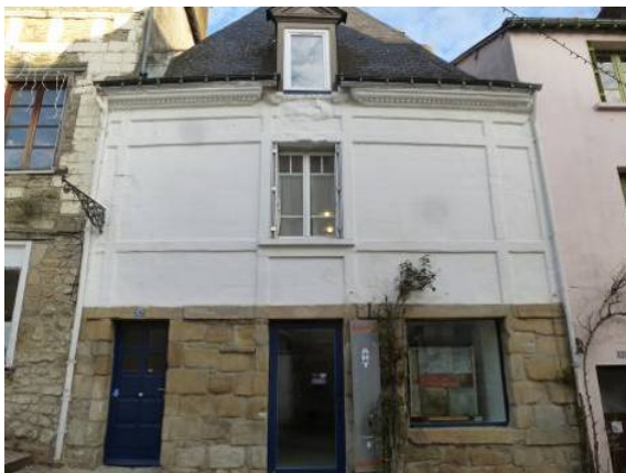
Rue du Château (17 e siècle)
