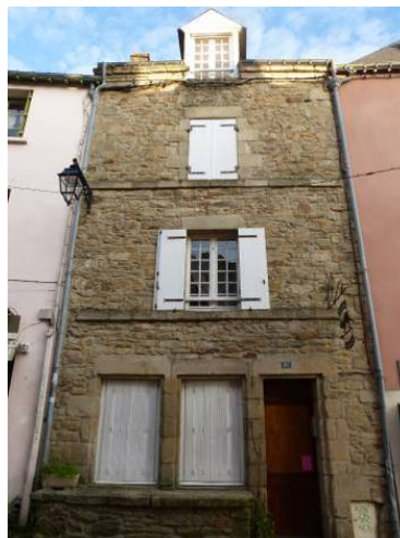
Rue du Château (17 e siècle ?)
