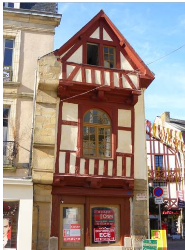
Maison en pan de bois du 16 e siècle à l'angle de la place de la République et de la rue du Belzic.
