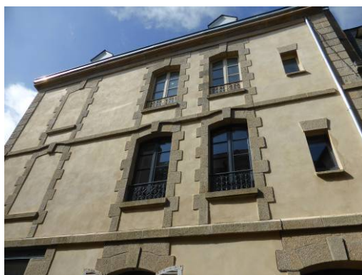
Rue du Château (19 e siècle)
