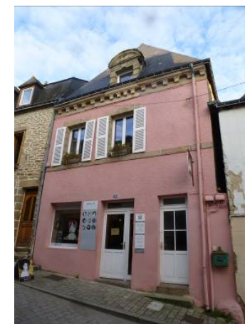
Rue du Château (17 e siècle)
