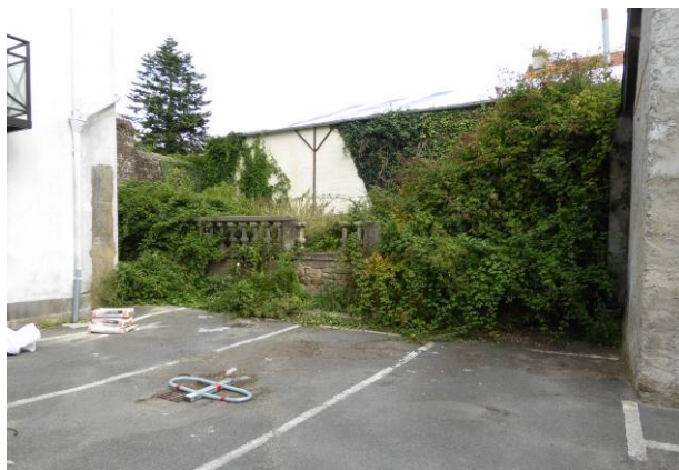
Le hangar du n°3 ou 5 depuis la cour du n°1 rue des Ecoles
