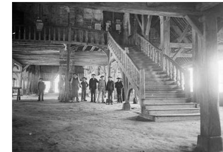
Vue intérieure. Photo Ministère de la Culture. Un escalier monumental en bois et balustres permet l'accès à l'ancienne salle de l'auditoire de la sénéchaussée.
