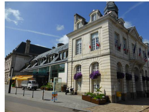
Les halles rebâties en 1998 entre l'Hôtel de Ville (1782) et le bâtiment consacré au tribunal et au Petit Théâtre (début 20 e siècle).
