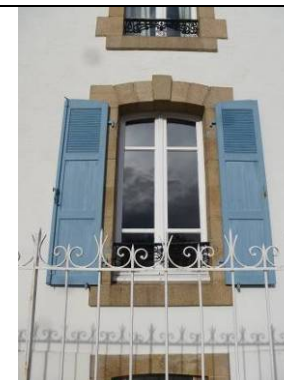
Rue du Sablen. Menuiserie à deux battants à 6 carreaux dissymétriques caractéristiques de la première moitié du 20 e siècle
