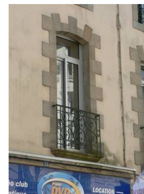
Rue Clémenceau. Menuiserie en aluminium à deux grands carreaux et imposte à dormant rectangulaire
