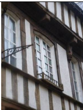
Rue du Petit Port, Saint-Goustan. Menuiserie à petits bois (20 e siècle) adaptée au tableau d'une fenêtre du 18 e siècle
