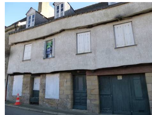
Rue des Frères Fèves. Les sablières de plancher supportées par les abouts de solives illustrent les deux niveaux supérieurs de la façade (étage et combles en surcroît)
