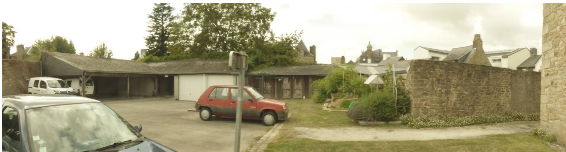
Le fond de la parcelle 456, 8 rue du Jeu de Paume, vue vers l'arrière la quincaillerie
