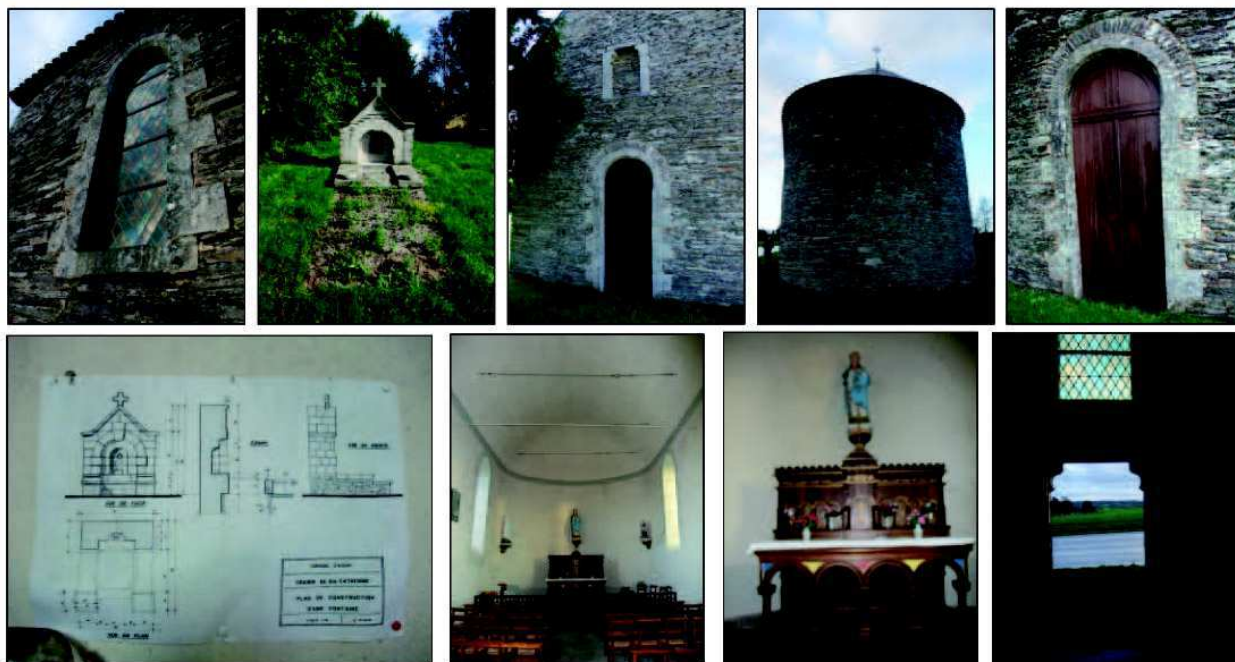
Détails architecturaux. Photos 1. à 5. Vues extérieures. Détails de baies, petit oratoire sur l'arrière, pignon principal et pignon arrondi, encadrement des portes et baies en pierre de taille et renfort en plaques de schiste.
