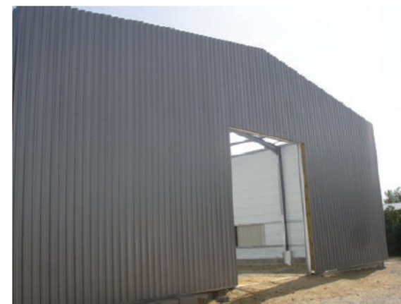
façade en panneaux sandwichs pour les ateliers techniques (à l'arrière du bâti principal).
