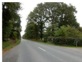
RD20 à l'Est de Ambon_large et balisée RD153 vers Muzillac_large et balisée
