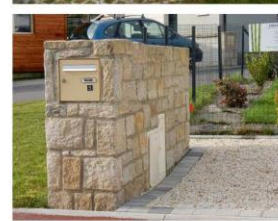
Introduction de murets techniques pierres locales
