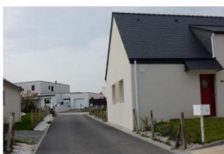
Pignon implanté sur rue_ZAC du Ponant
