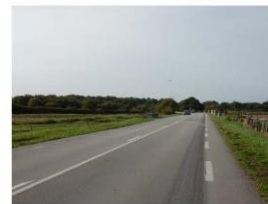
RD140 vers Damgan_large et balisée Commune vers Brouel_étroite et sinueuse
