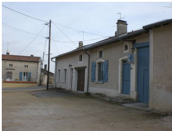
Constructions aux alentours, le long de la rue Jeanne d'Arc
