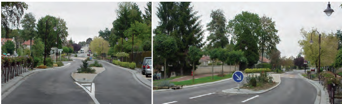
Aménagement d'un îlot central / Effet de chicane
