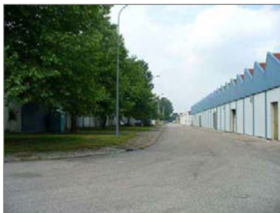
Un exemple de toitures shed.
