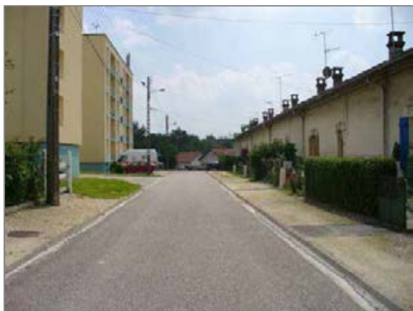
Les cités ouvrières et les immeubles collectifs du quartier du Bouvret.
