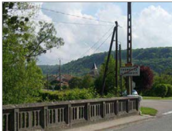
Vue sur le bourg depuis le pont sur l'Ornain.
