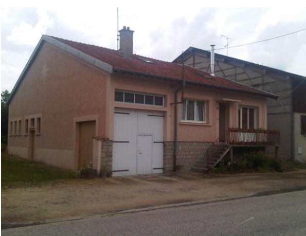
Ancien rénové avec enduit teinté rose
