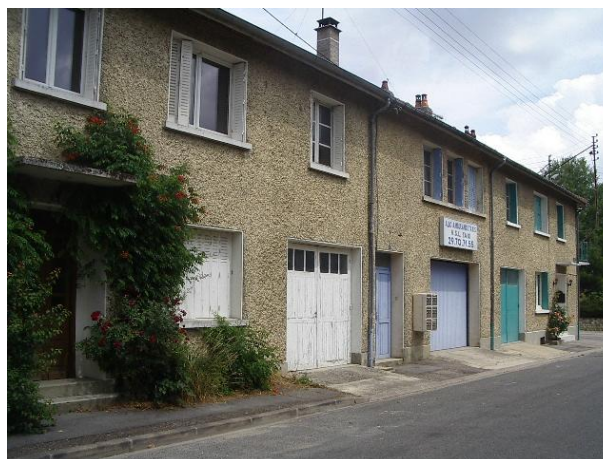
Façade typique de la reconstruction
