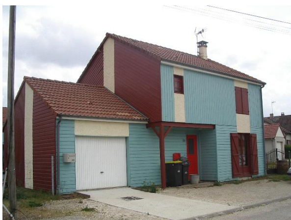
Construction standardisé Voie de Beaulieu
