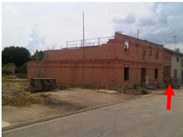
Suite démolition, reconstruction en contiguïté
