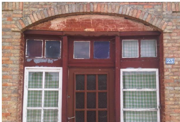
Facade de la briquetterie
