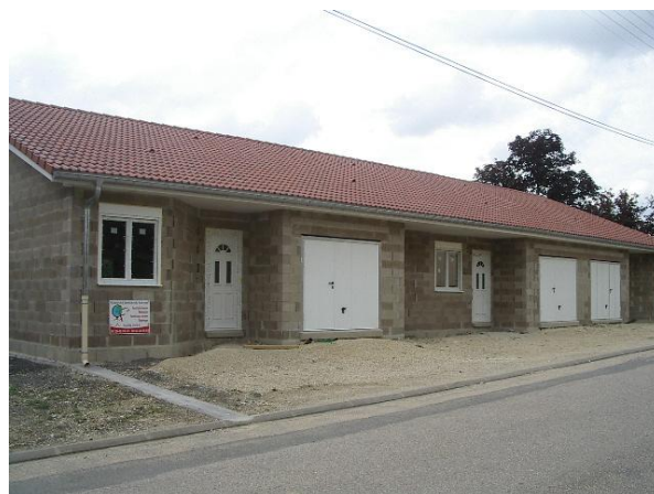
Locatif contigu en construction
