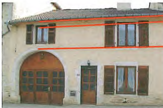
Alignement des linteaux
