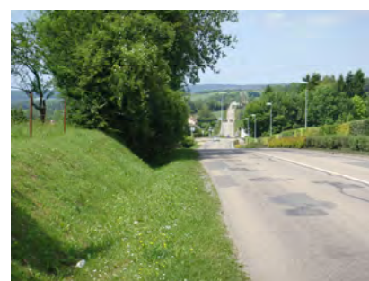
Vue inverse depuis la RD.964 (Avenue des Ardennes). Au loin, vue sur le giratoire.
