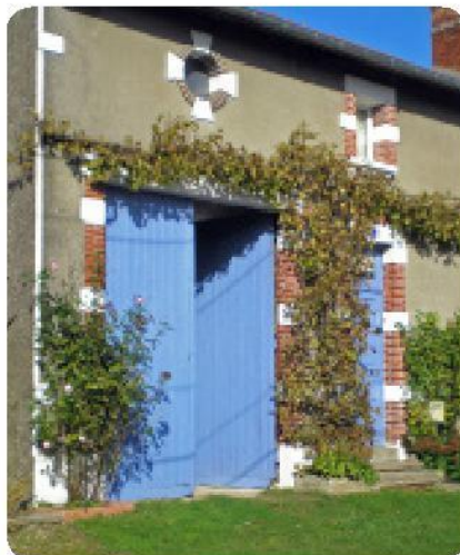
1 Neuville-en-Argonne, porte charretière à linteau droit
