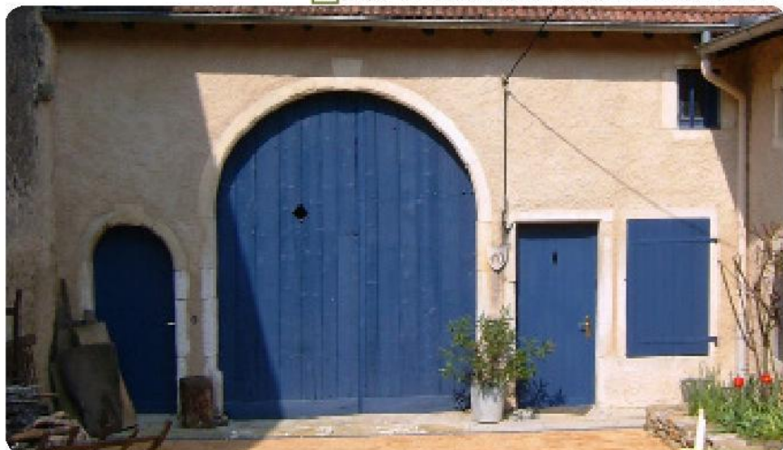
4 Brixey-aux-Chanoines, porte charretière en plein-cintre
