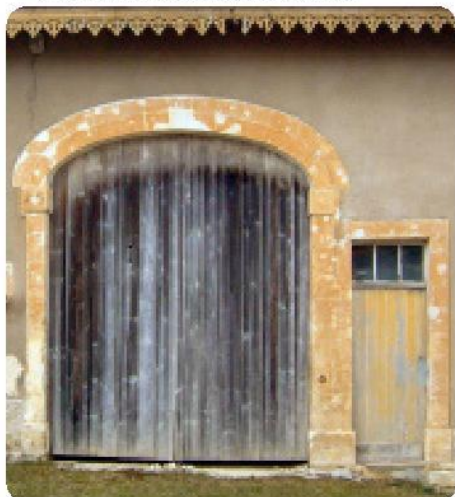
3 Autrécourt-sur-Aire, porte charretière en anse de panier
