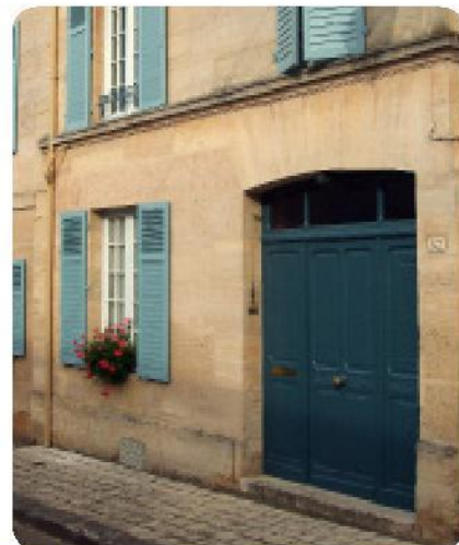
2 Ville-sur-Saulx, porte charretière à plate-bande cintrée
