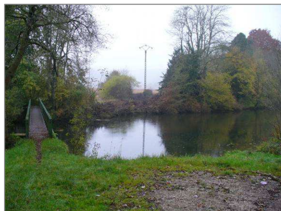
Passerelle en fer qui permet la traversée.
