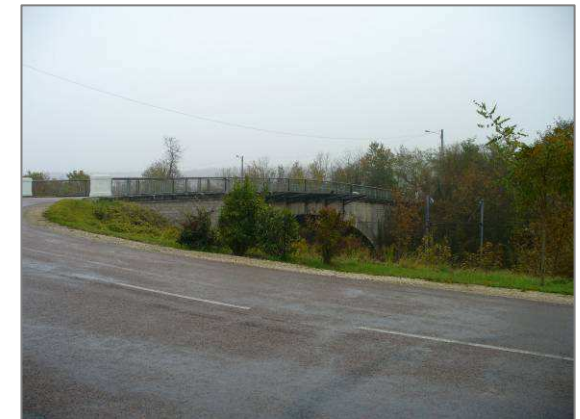
Le pont, au dessus du chemin de fer.
