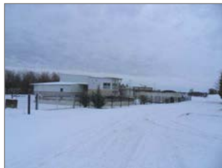
Station de traitement des eaux.
