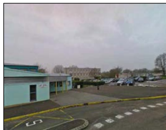
Complexe scolaire, rue du Moulin.
