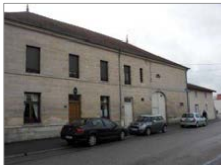
Façade en pierre taillée, Rue Ste Barbe.
