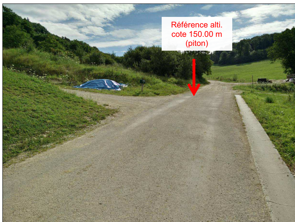
Figure 6 : Positionnement des références altimétriques locales
