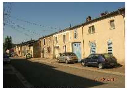
34 Grande Rue (0096) sur-épaisseur d'enduit
