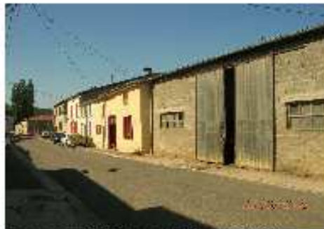
hangar 20 Grande Rue (0098)
