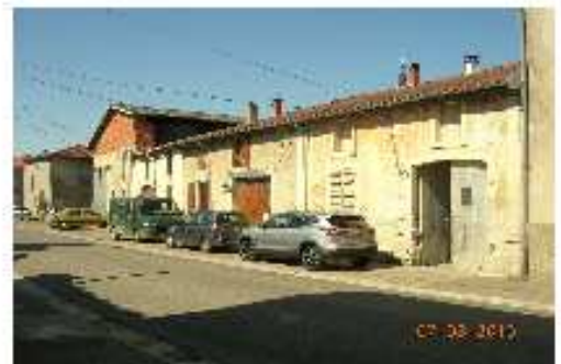
10 Grande rue (0102) réhabilitation partielle à conforter
