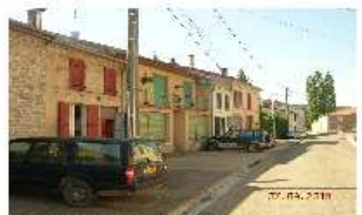
19 Grande Rue (0101) retrait étage avec terrasse sur rue
