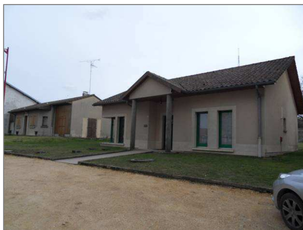
Construction récente au cœur de la trame ancienne.
