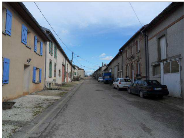
Alignement des constructions, rue Bourgeoise.
