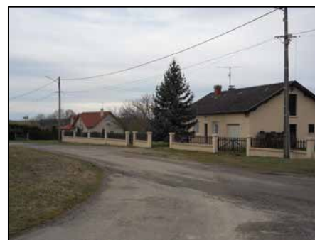
Pavillon chemin des Ruets
