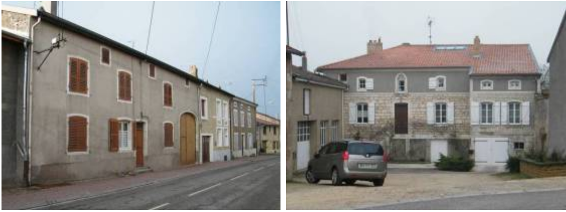
Façades remarquables par l'alignement vertical et horizontal des ouvertures
