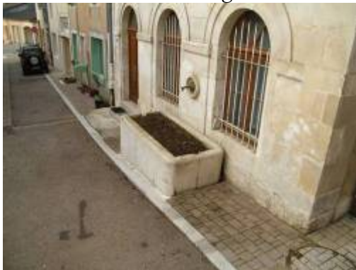
Elément n°9-Rue de l'Eglise
