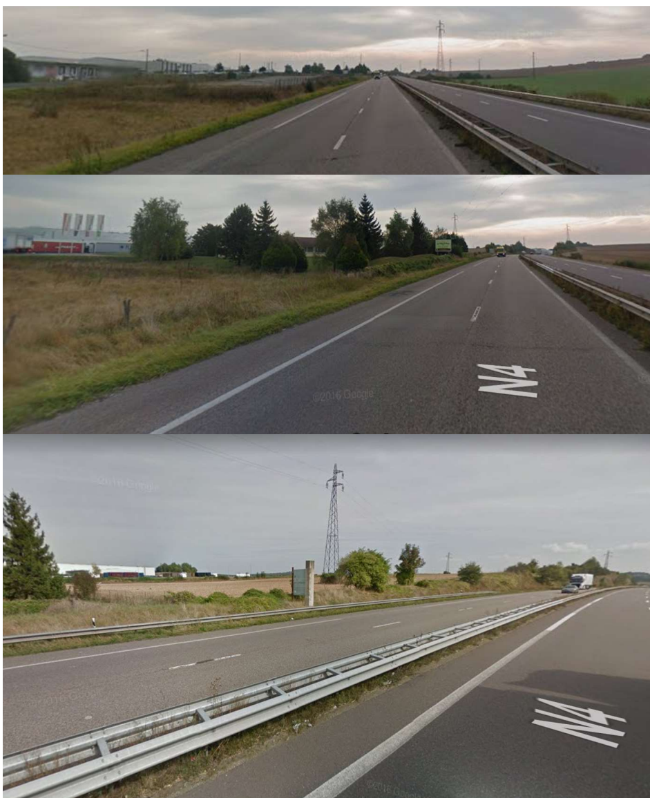
Vues sur le secteur 3 depuis la RN 4
