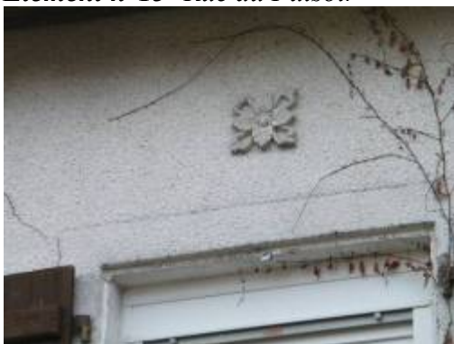
Elément n°13- Rue du Puitsoir
