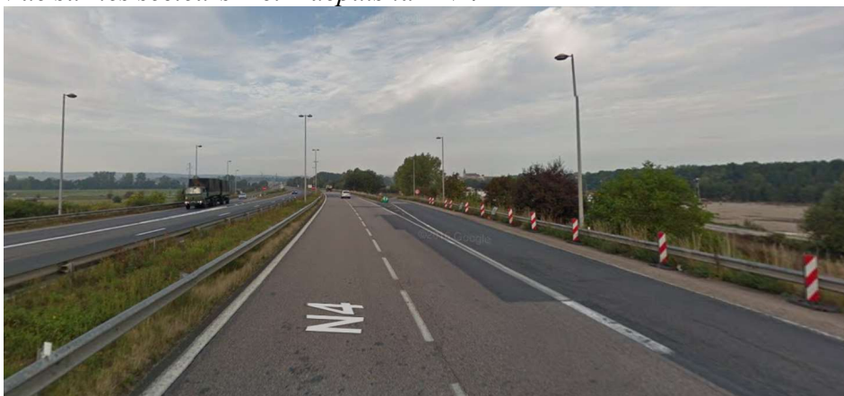
Vue sur les secteurs 1 et 2 depuis la RN 4
