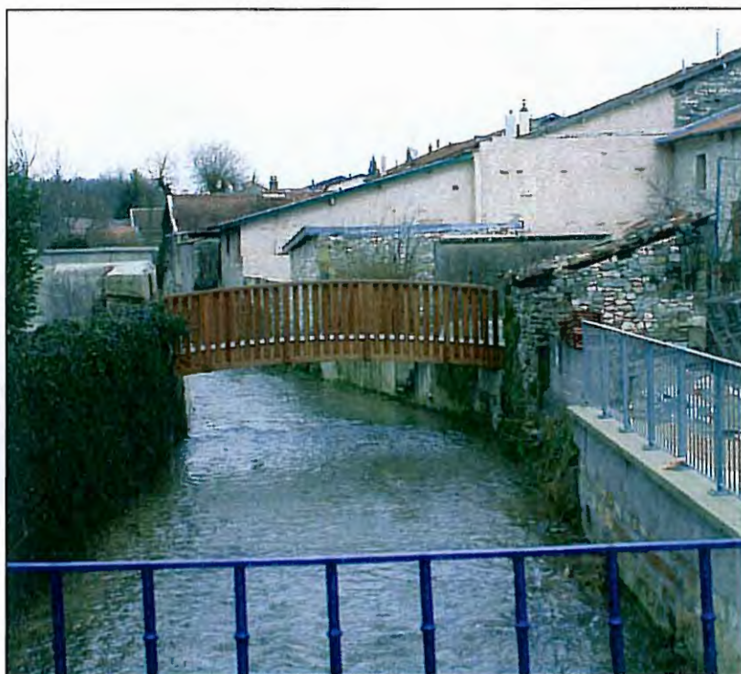
Passerelle permettant le Passage au-dessus du Naveton à Naives-devant-Bar
