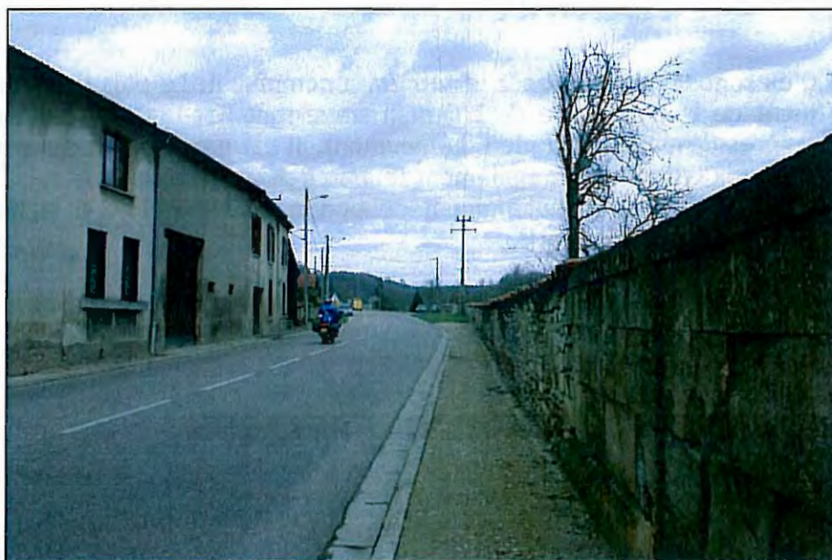
Mur d'enceinte du parc 18-19ème siècle continuant l'alignement de la Voie Sacrée
