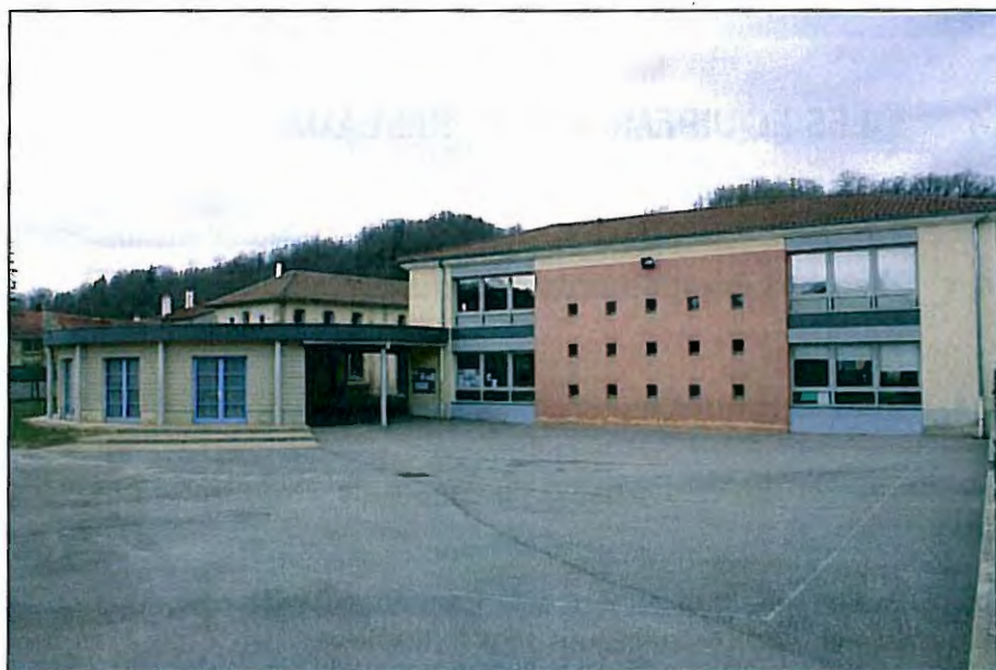
Ecole dépendant du syndicat intercommunal
