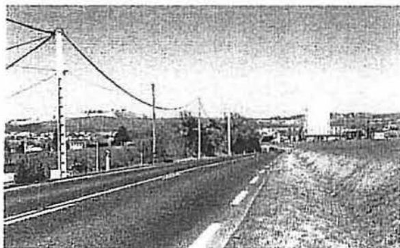
RN 43, arrivée en provenance de Longuyon, vue 1
