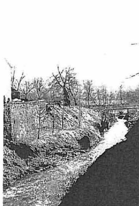
Déviation de la Chiers, le long des ateliers municipaux
