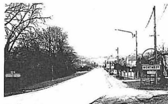
RN 43, arrivée en provenance de Longuyon, vue 3
