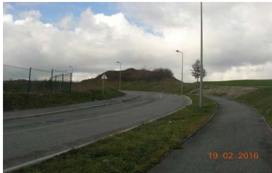
Voie d'accès et contre-voie liaison douce
