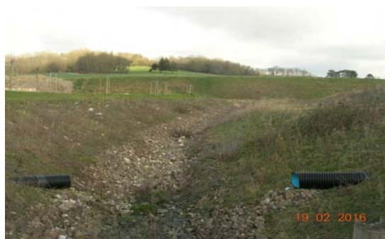
Noue pour la rétention eaux pluviales
