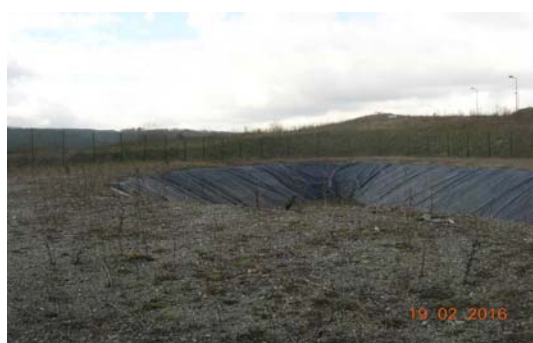
Bassin de rétention sur la zone 1AUx
