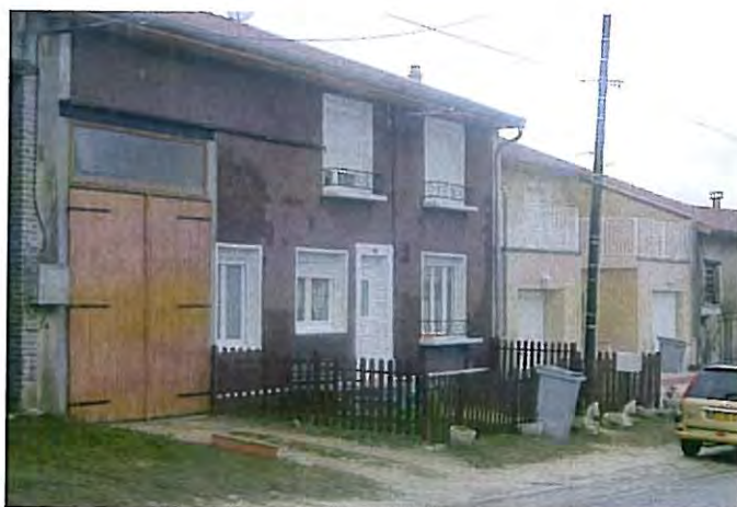
Façade lorraine ayant subi des transformations et dont l'usoir a été clôturé
