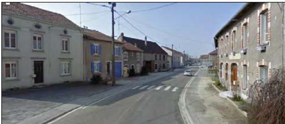
centre ancien – rue du Général De Gaulle
