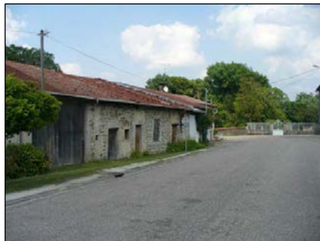
Habitations anciennes-voie sacrée Issoncourt
