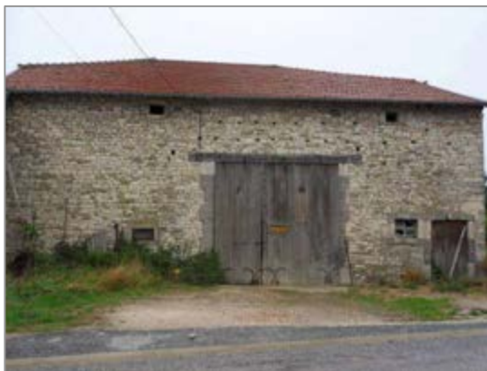
Ancienne grange, Mondrecourt.
