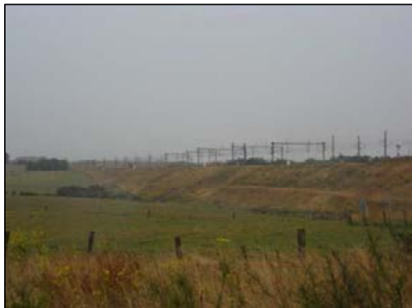
Emprise de la LGV
