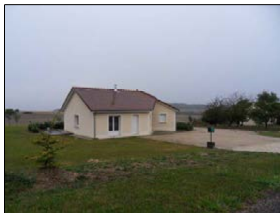
Pavillon chemin de Beaumont, Issoncourt.
