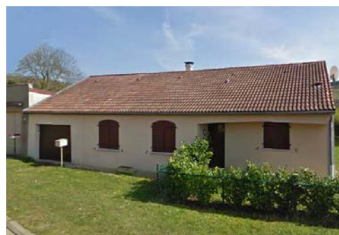
Habitation située rue du Haut du Retour
