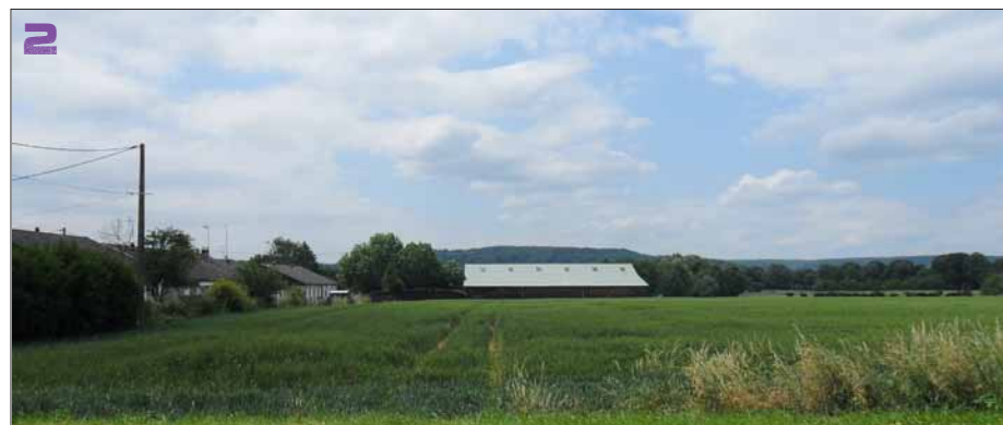
Présence d'habitations fortement perceptibles depuis la RD 904
