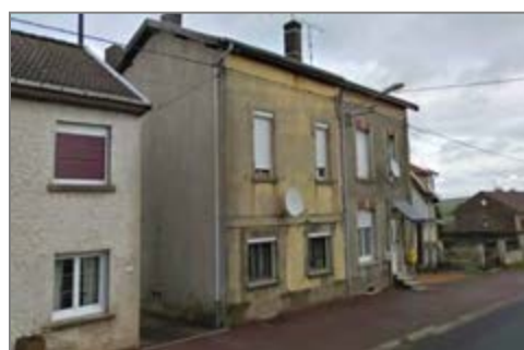
Deux maisons ouvrières mitoyennes au bord de la D106, côté est de la voie ferrée. La maison sur la gauche semble plus contemporaine.
