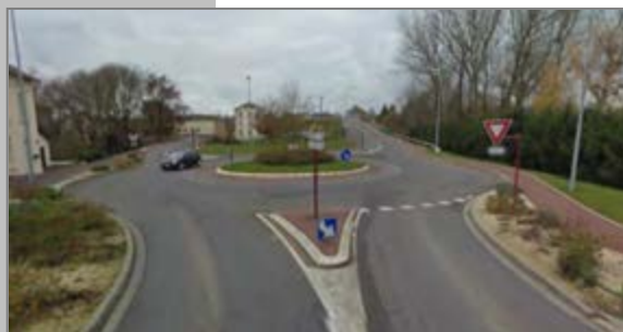
Rond-point aménagé sur la D106.
