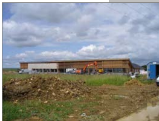
La nouvelle école en chantier en 2013.
