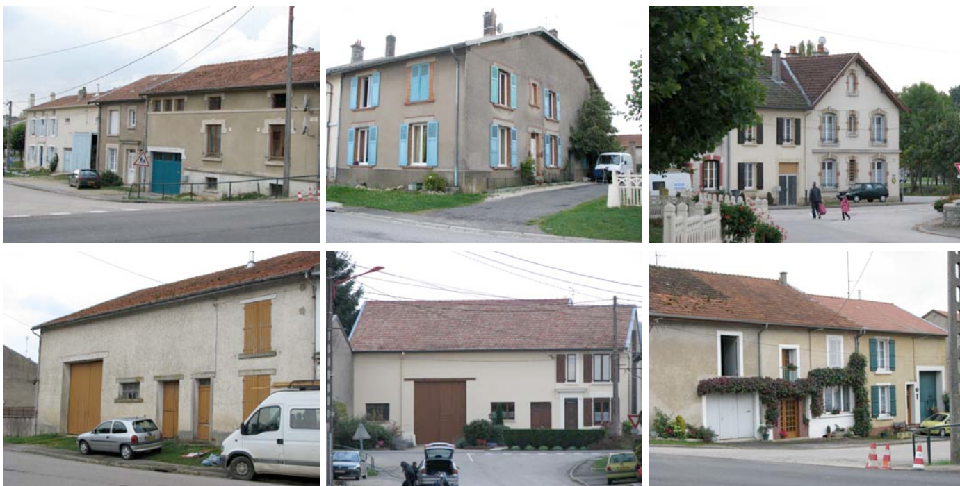
Le bâti ancien à Consenvoye
