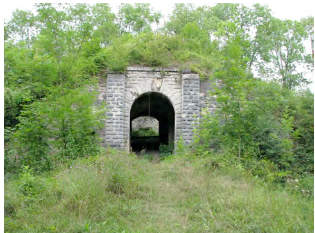
Les vestiges du Fort de Belleville
