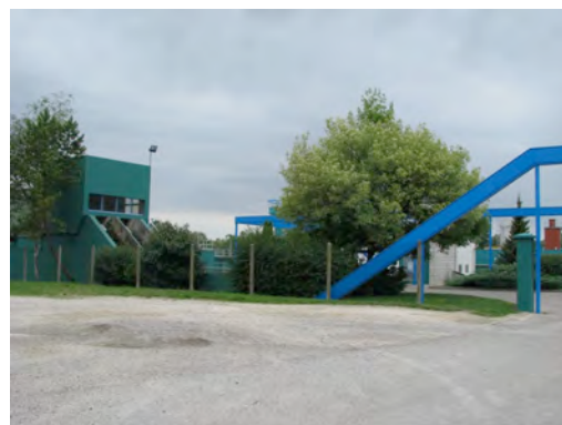
La station d'épuration
