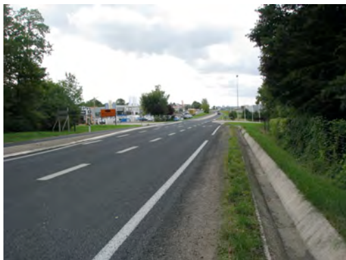
Entrée de ville en venant de Bras-sur-Meuse par la RD 964
