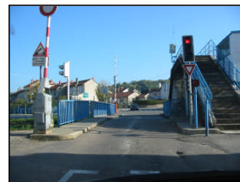
Franchissement du canal par Pont Levis
