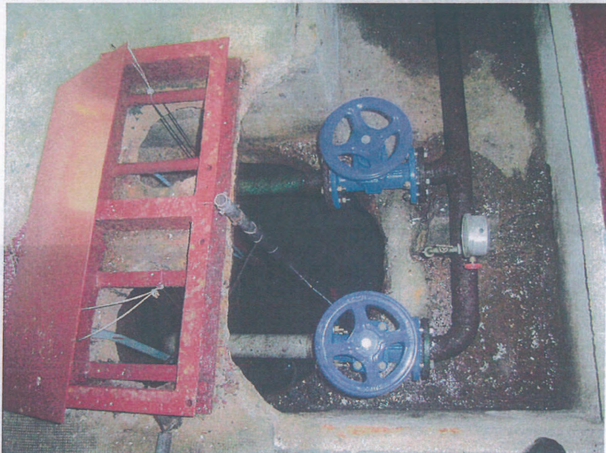
Le captage - la tête du puits
