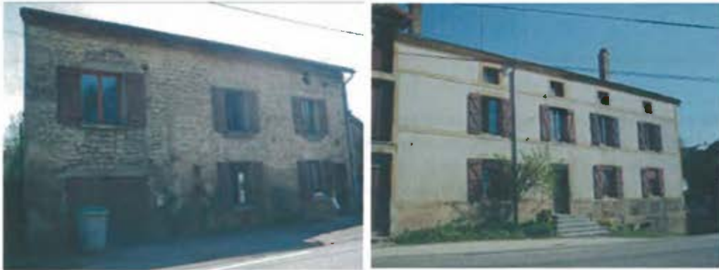
Des façades composées d'ouvertures régulières et de volets en bois (persiennes) pour la majorité des constructions.
