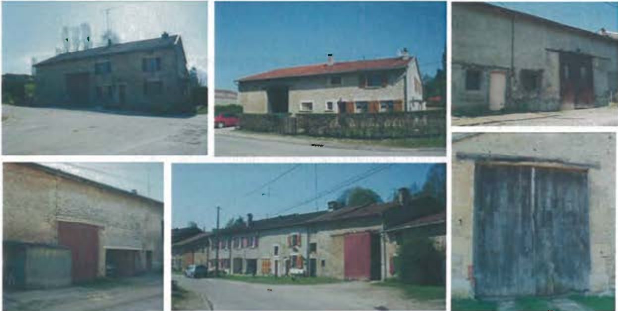
Des portes cochères avec de fréquents linteaux en bois, qui renforcent le caractère rural de la commune de Baâlon.
