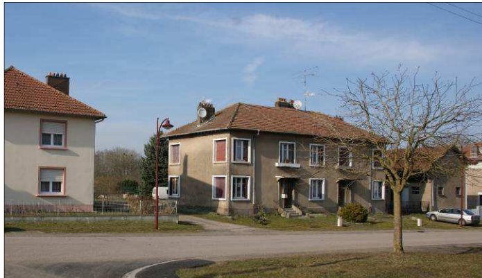
Habitations issues de la période de la reconstruction
