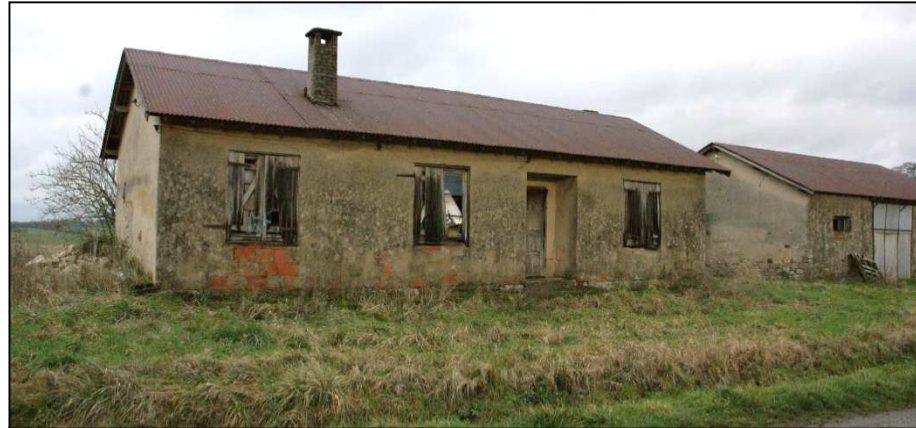
Ancienne habitation construite peu après la Première Guerre mondiale et aujourd'hui utilisée comme lieu de stockage par un agriculteur. S'agissant à l'origine d'une habitation, ce bâtiment ne peut être considéré comme du bâti mutable.
