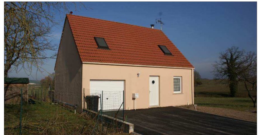
Habitation construite au coup par coup du chemin du bois du Chêne
