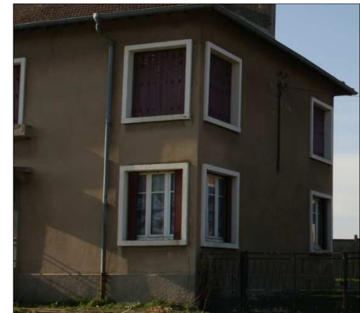
Encadrements de fenêtre datant de la reconstruction
