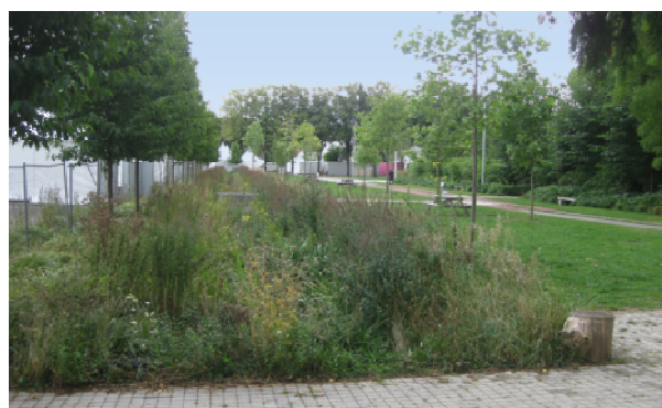
Parc François Mitterrand (Saint-Etienne) : noues et fossés de stockage végétalisés
