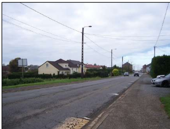
RD 618 dans sa traversée du village
