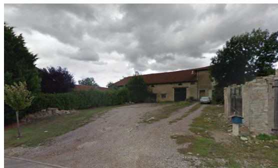
Bâtisse sur cour.
