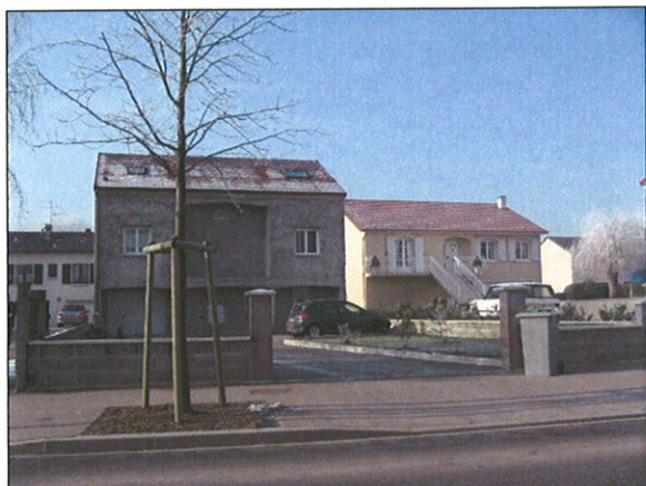
Pavillons, rue Charles de Gaulle : implantation indépendante de celle des parcelles voisines.
