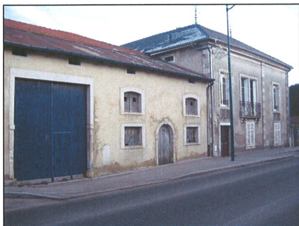
Maison rurale dans l'alignement de la rue Charles de Gaulle.
