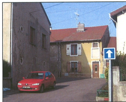
Maison d'ouvrier avec gerbière, rue Fayon.
