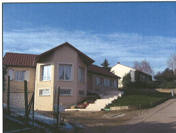
Pavillon récent, chemin de la Côte : volumétrie complexe, toiture multi-pans, entrée surélevée.
