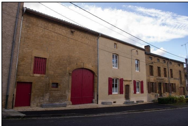
Constructions mitoyennes en partie basse de la rue du Château.
