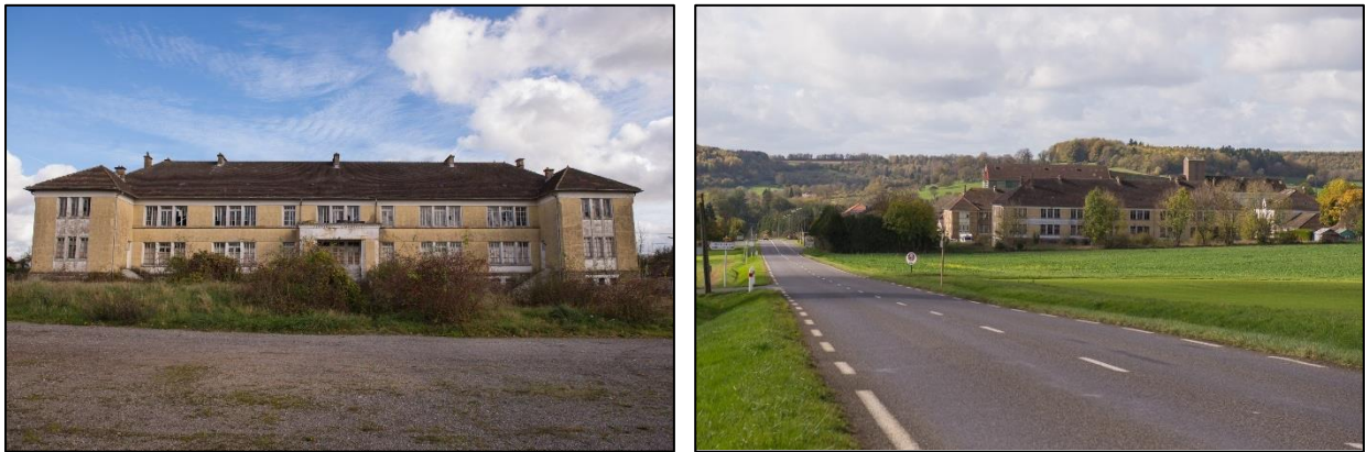
Vues de l'aile Est des casernes depuis l'ancienne cours intérieure (à gauche) et depuis la RD643 (à droite).
