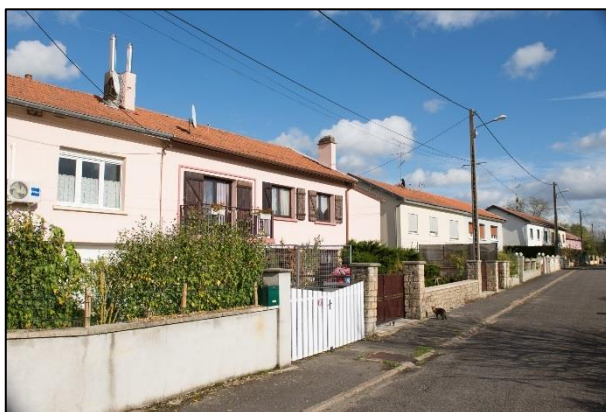
Constructions récentes rue des Capucins.
