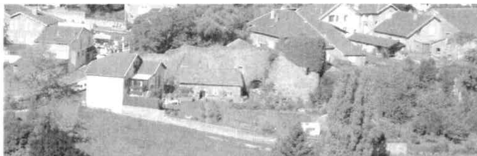
Vue du mur et de la tour d'Urtal (GB Air Photo – Commune de Mousson)
