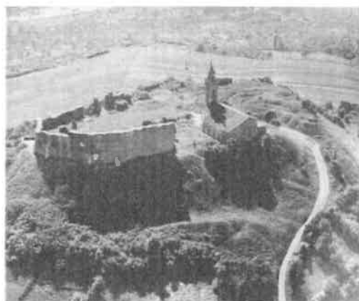
Vue aérienne du château et de l'église vers 1930 (Archives du Musée lorrain)
