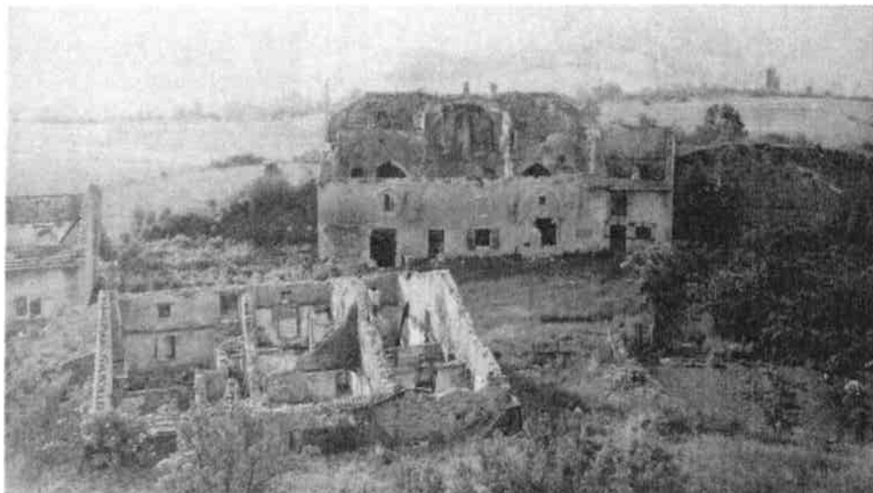
Maisons partiellement détruites par les combats de 1944 (AD54 2Fi 4692) révélant des structures caractéristiques de la maison lorraine
