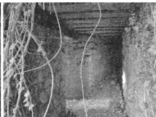
Intérieur du poste optique n°2 (Les Amis du Vieux Mousson)
