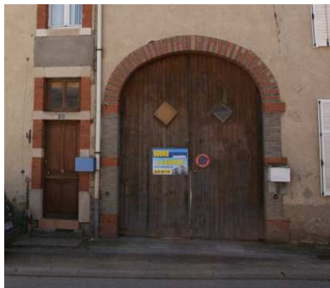
Encadrement de porte et fenêtres en briques
