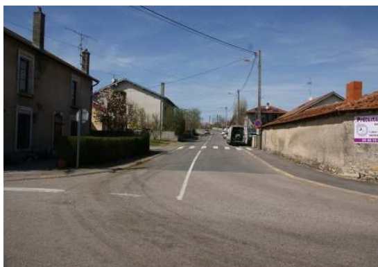
Route de Drouville : avec aménagement et moyen de franchissement piétonnier
