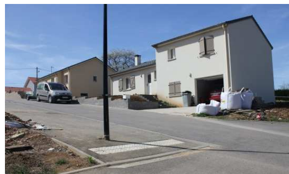
Lotissement d'habitations en construction rue du Grand Verger
