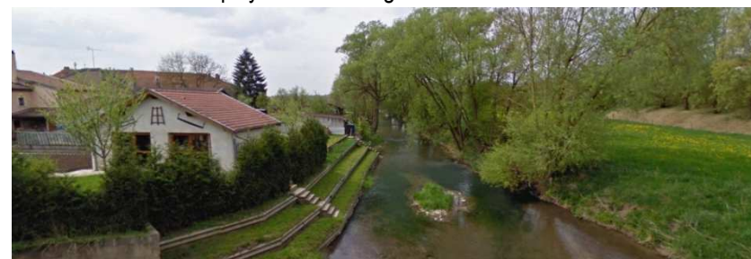
Le Sânon bordé de ripisylve sur la berge naturelle
