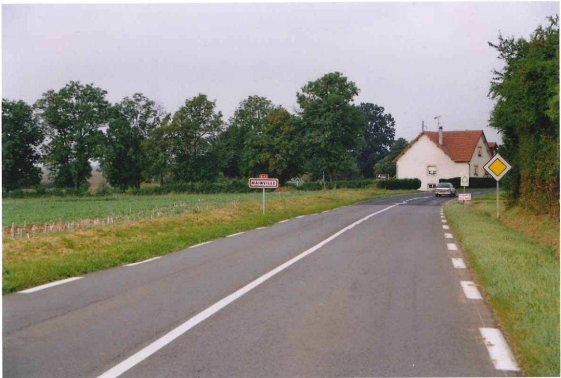
Entrée de MAIRY-MAINVILLE, côté MANCIEULLES, par RN43.
