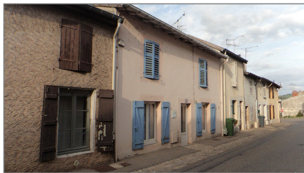
Maisons de village, rue du Bois le Prêtre
