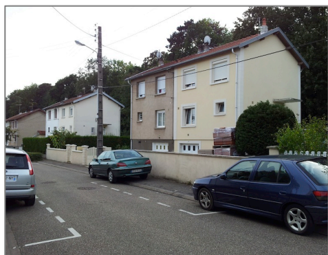
Maisons jumelées, rue des Quatre Frères Guillon (Champ Clos)
