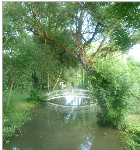
Grand Rupt au droit de la traversée avec la RD958
