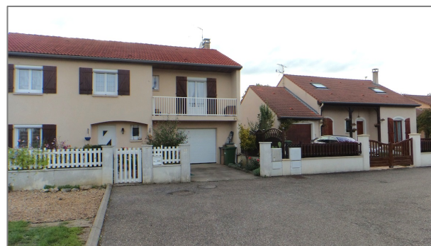
Pavillons, le Clos des Vignes
