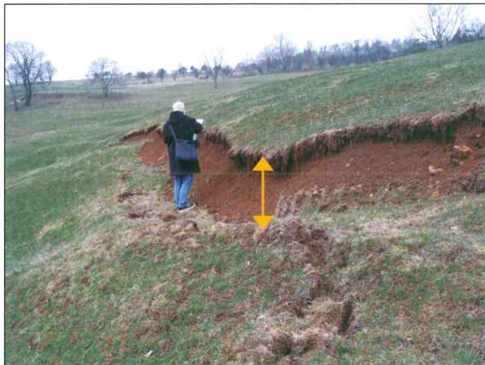
Décrochement de tête de 1m de haut sur 10 à 15m de long
