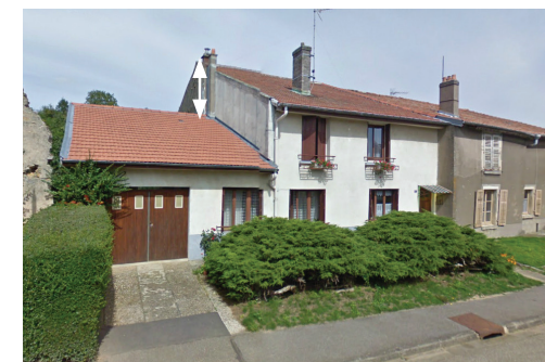
Décrochage vertical entre les faîtages :
