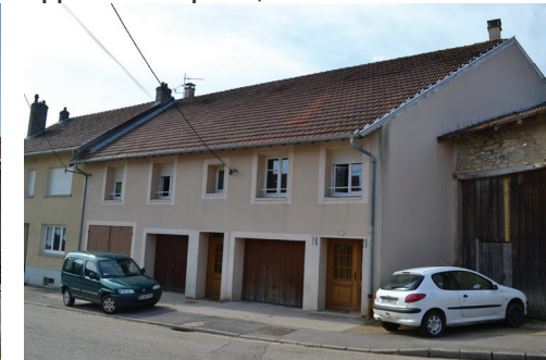
Appartements privés, rue de Bellevue :
