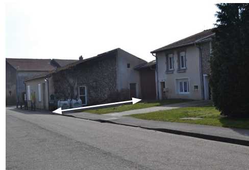
Décrochage horizontal entre les façades :
