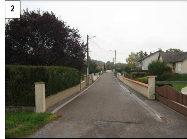
Chemin du Pré Hali, aucun trottoir, rue étroite pour un passage simultané de deux automobiles.
