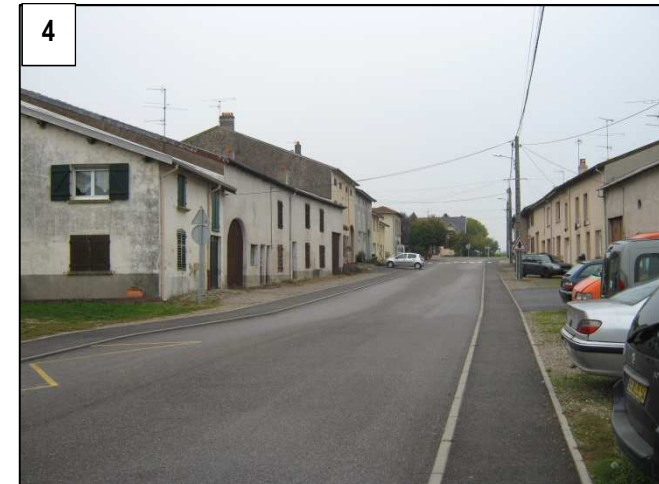
Rue de Rosières, large route avec trottoir des deux côtés de la voirie. Un passage piéton est présent.
